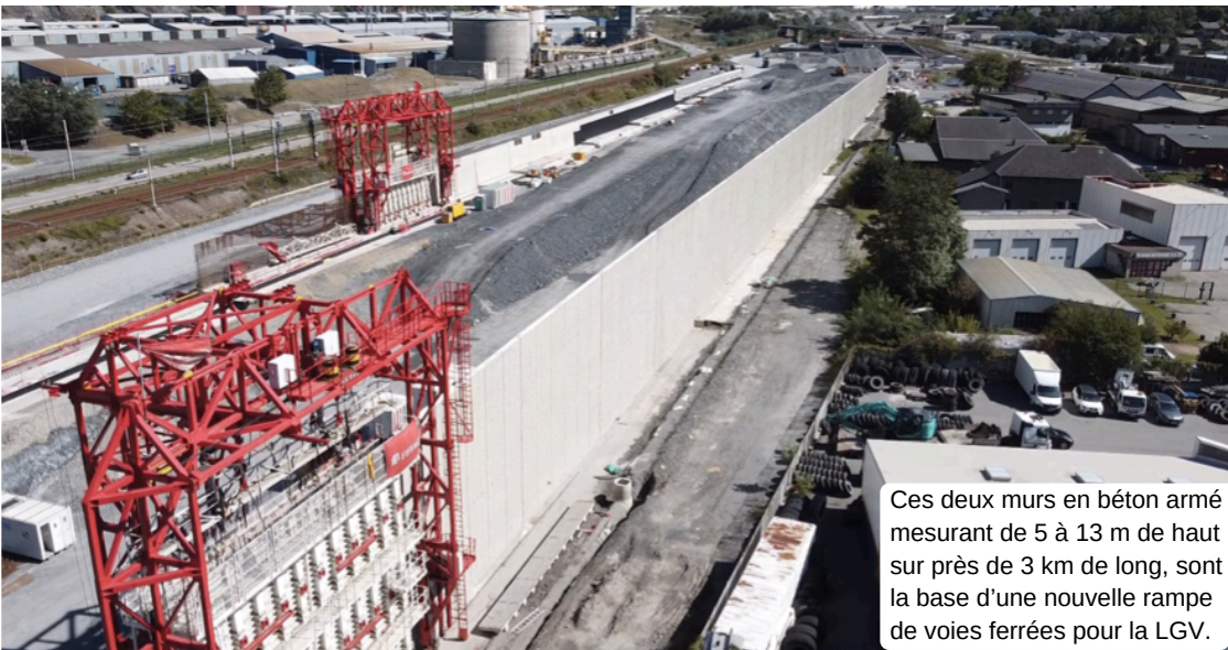
Octobre 2024. Les travaux ont une emprise totale de 54,61 ha sur les communes de Saint-Jean-de-Maurienne et Villargondran.
